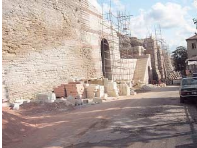
2-4 テオドシウスの城壁の修復作業
