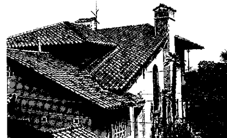
⑪ 旧泉勤一郎邸 昭和9年 西宮市 設計=大林組住宅部
